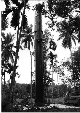
รายละเอียดโครงการ : โครงการก่อสร้างระบบบำบัดน้ำเสียชุมชน หมู่ ๔ ตำบลบางนาค อำเภอเมือง จังหวัดน่าน ๑๐๐,๐๐๐-บาท และติดตั้งแมลงวันจิ๋ว ๒๐ x ๒๐ เมตร จำนวน ๑๐๐ ตัว ภายในปีงบประมาณ ๒๐๑๖
