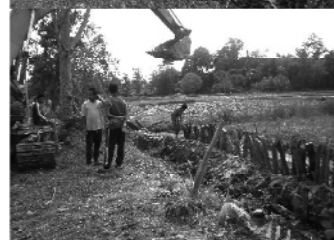
รายละเอียดโครงการ : โครงการปรับปรุงหนองน้ำเพื่อป้องกันและแก้ไขปัญหาน้ำท่วม หมู่ที่ ๔ (ชุมชนบางนาค) ตำบลบางนาค อำเภอเมือง จังหวัดน่าน ๑๐๐,๐๐๐-บาท
